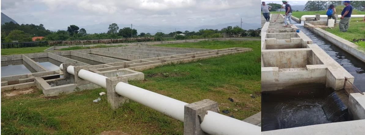
Figura 10. Izquierda; Sistema de filtrado de agua, Derecha; Entrada del agua al filtro y primer sistema de filtrado.
